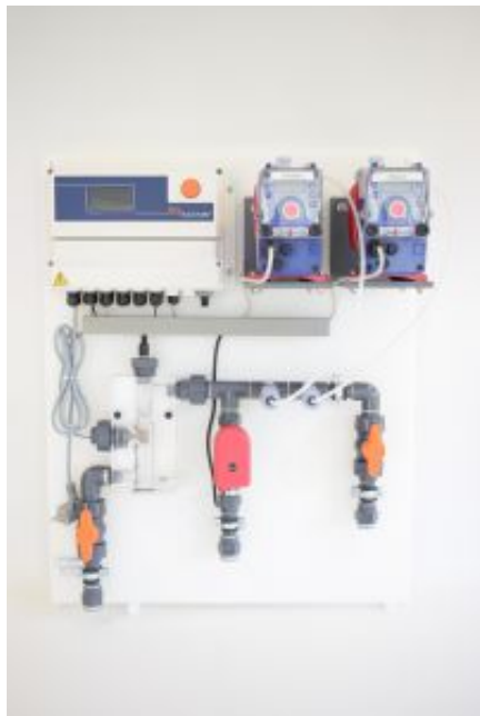
Beispielanlage Kühlturmüberwachung
