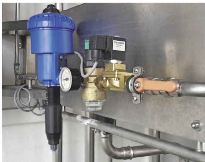
LDT-Dosatron-Ausführungen D25RE2 in PVDF und D25RE10 mit By-Pass-Schalter im Leitungsnetz installiert
