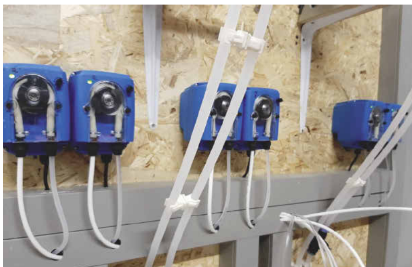
Die Schlauchpumpen B3-V 12/1 von LDT Etatron fördern die Salzlösung aus den Dosierbehältern in die Anlagen
