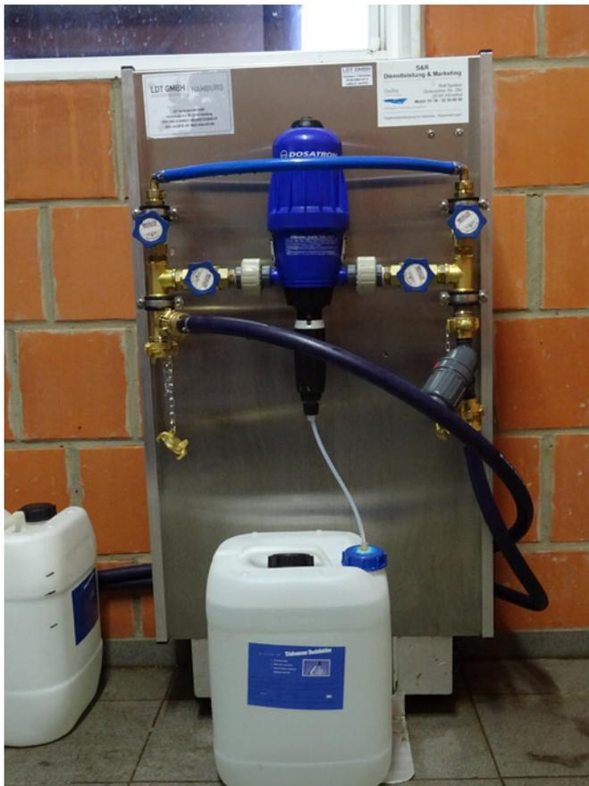
Mobile Spül- Reinigungs- und Desinfektionsstation
